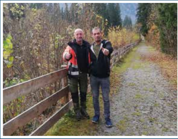
RENOVIERUNG DES ZAUNES AM DRASSNITZBACH - DANKE UNSEREN FLEISSIGEN ARBEITERN KLAUS BAUMGARTNER UND CHRISTIAN WALTJ
