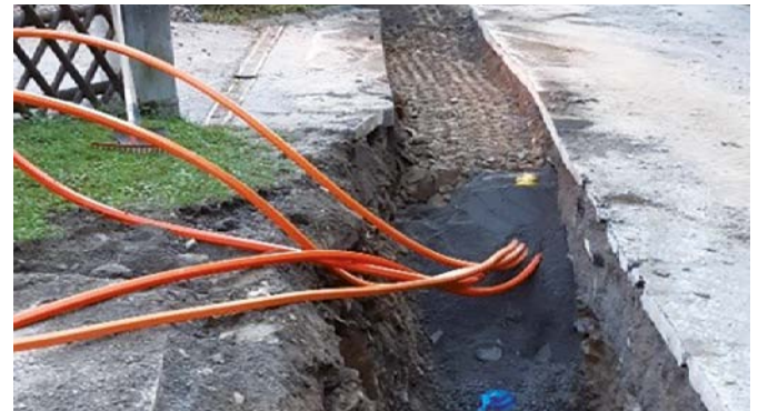
Trinkwasserleitung mit Warnband und Multirohrverbände für den Lichtwellenleiter
