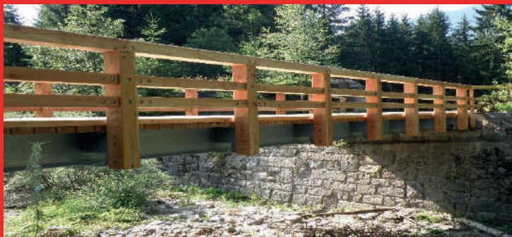
Projekt in Planung: Sanierung Draßnitzbachbrücke
